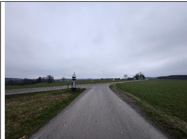
Voirie communale en direction de Hubermont : voirie asphaltée
