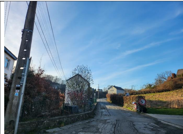
Début de la rue Corniche du Deister : voirie asphaltée
