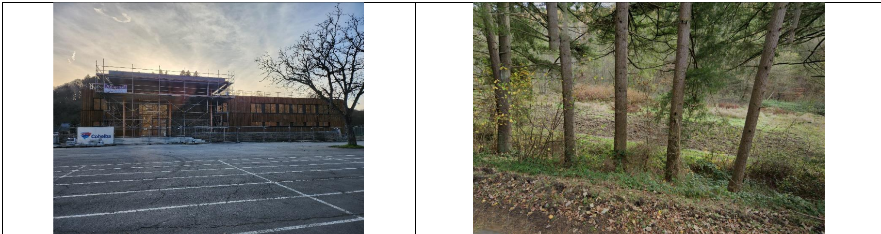
Complexe sportif en rénovation en 2023 rue de la Piscine
