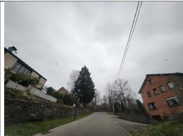
Rue du Bon Dieu de Maka : voirie asphaltée
