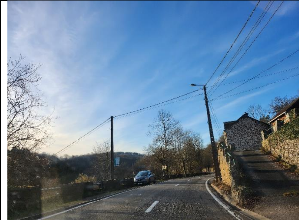
Traversée de Villez et N860 : voirie asphaltée
