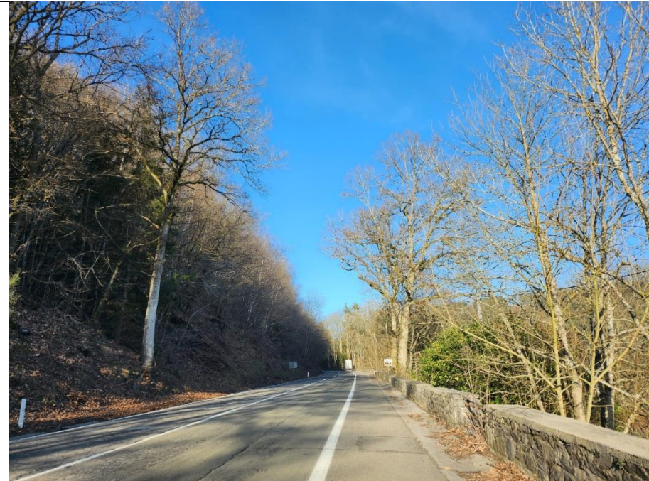
N860 de Maboge : voirie asphaltée
