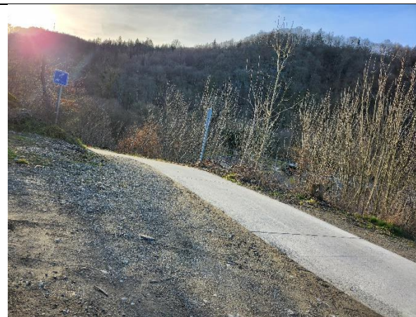
RAVel : voirie bétonnée
