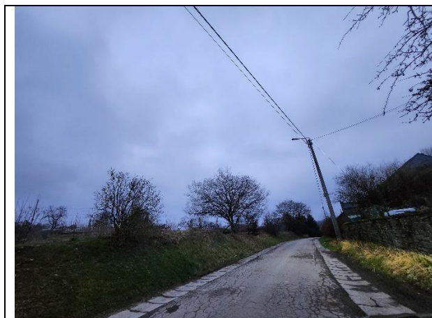
Sortie du village de Nisramont : voirie asphaltée puis chemin empierré
